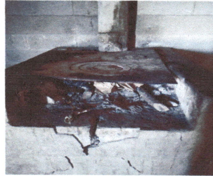
Foto 2: Área donde se cambiará la plancha y repello de pared de la cocina del centro educativo
