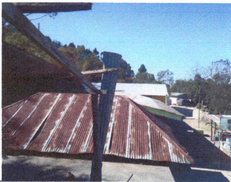
Foto 3: Cambio de techo de la cocina escolar.
