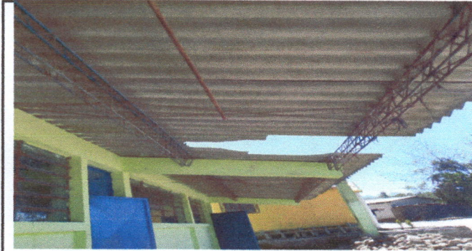
Foto 1: Área de cambio de techo de duralita de uno de los módulos por lámina troquelada aluzinc calibre 26
